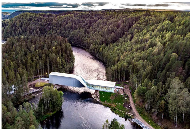
Figur 11.25: Kistefos museet The Twist og et grund-design af bygningen, med glasfacader, via et Cosserat sweep: Et lodret rektangel roteres effektivt og kontrolleret med R_x(f(t)) igennem vinklen \pi/2 langs den simple fodpunktskurve p(t) = (t, 0, 0) .
